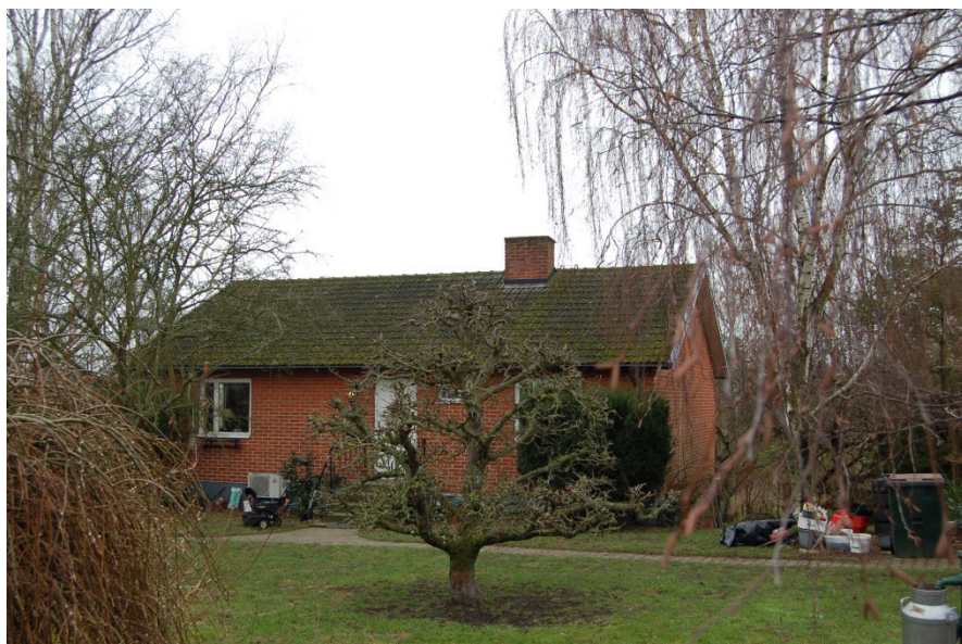
Figur 27. Villa , Fridhillsvägen 10. Objekt nr. 62 i tabell 1.
