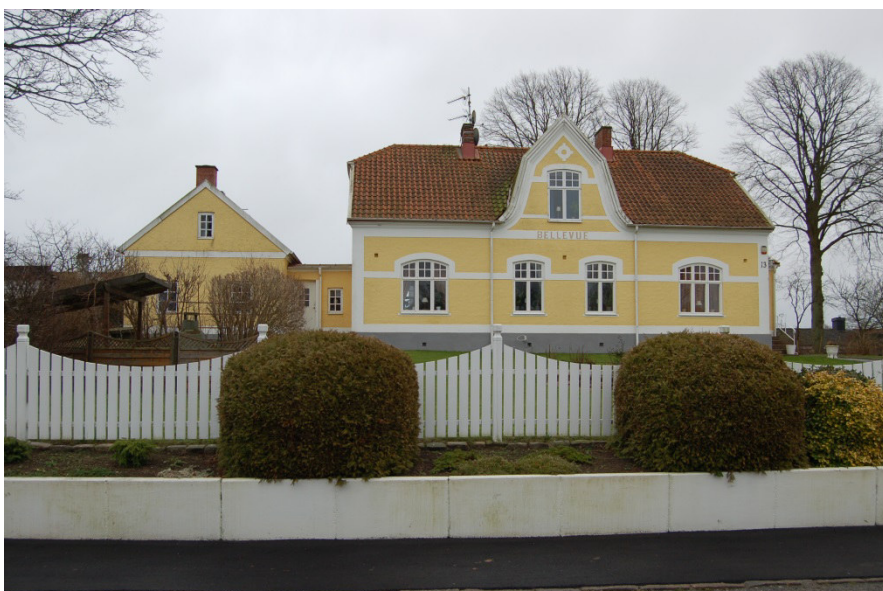
Figur 15. Villa Bellevue är ett fint exempel på en karaktärsvilla längs Hybyvägen. Objekt nr. 27 i tabell 1.
