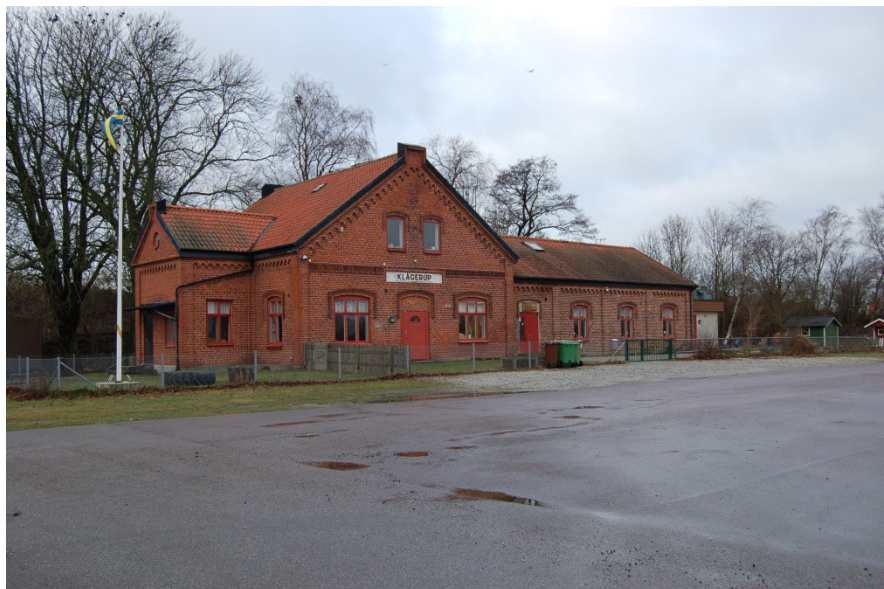
Figur 9. Stationsbyggnaden används idag som dagis. Den äldsta delen är lågbyggnaden från 1875 medan den större byggnaden byggdes till år 1894. Objekt nr. 1 i tabell 1.
