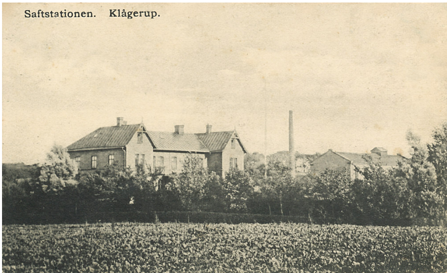
Figur 5. Kontorsbyggnad och saftstation före 1918.
