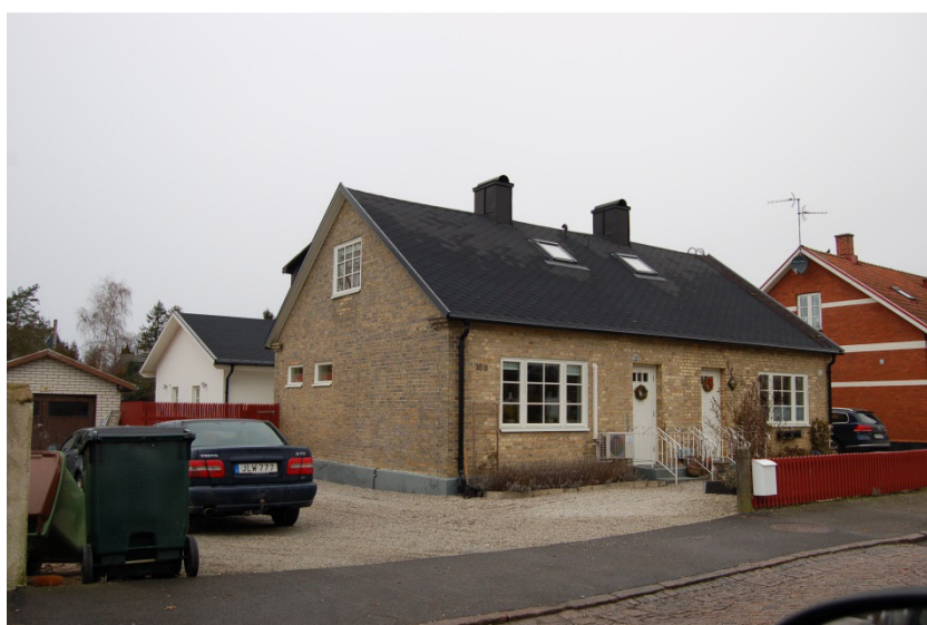
Figur 18. Parhus, Hybyvägen 16A-B. Objekt nr. 40 och 41 i tabell 1.
