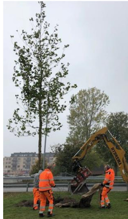
Figur 62 Plataner planteras utmed Värbyvägen i Bara tätort
